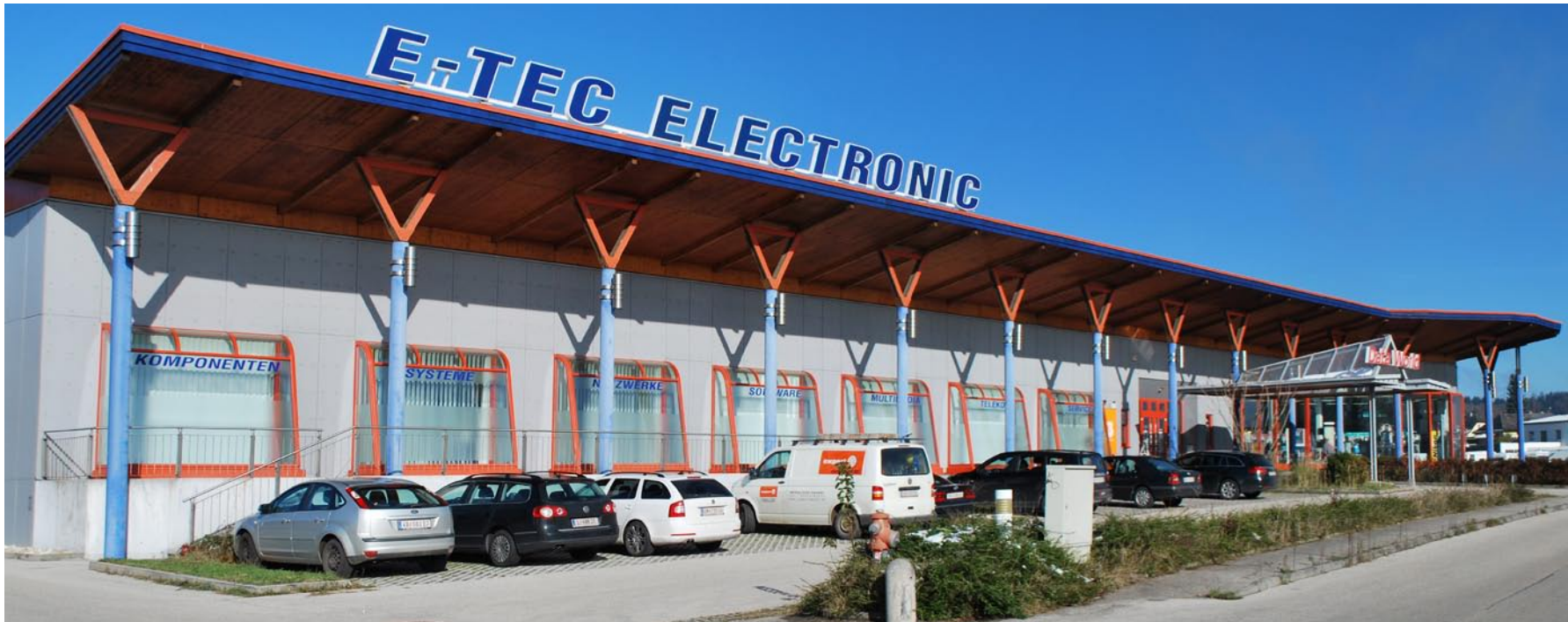
Das Unternehmen e-tec mit seiner Zentrale im oberösterreichischen Timelkam (Bild) verfügt mittlerweile über 15 Standorte.
